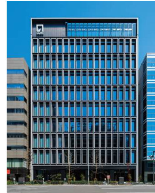
S-GATE大手町北
