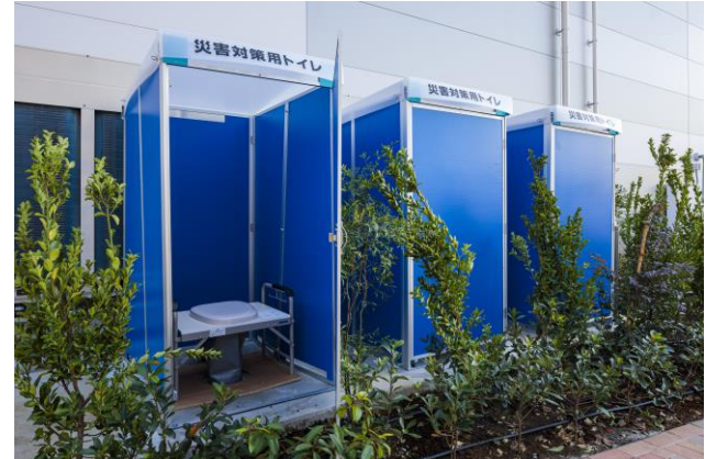
マンホールトイレ
