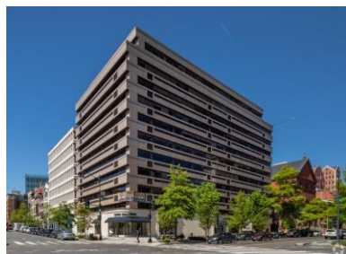
現況建物外観
