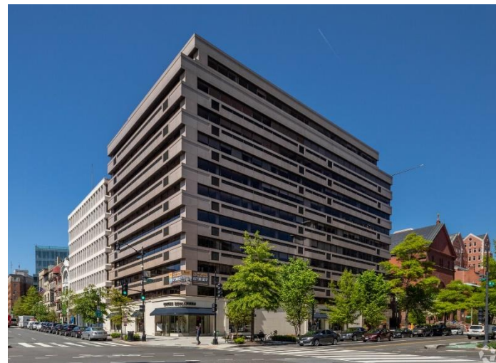
現況建物外観
