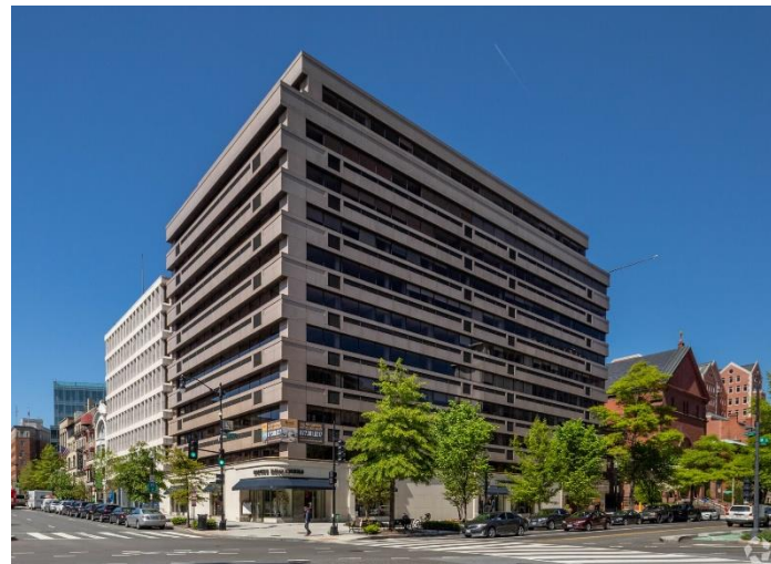
現況建物外観
