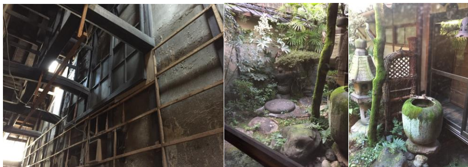
（第1号物件：写真は全て改修工事前）
